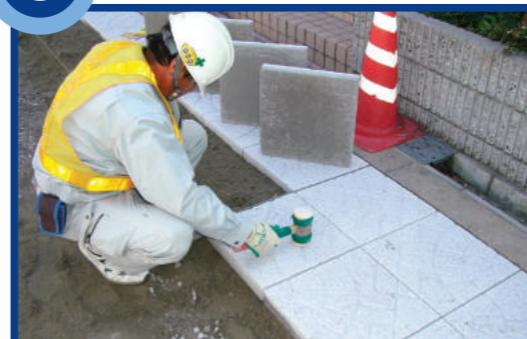
仕上がり後に所定の設計基準面が得られるよう、敷きならした敷きモルタルの上に平板を置き、水糸の高さと面一になるまでプラスチックハンマーか木片を介したハンマーなどで平板表面を十分にたたき込み、平板がしっかりと固定するように圧着据付を行います。
