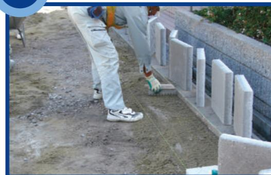
基準線やベンチマークに基づき、水糸を中継みなく強く張り、平板の仕上がり高さを設定します。この水糸にあわせて敷きモルタルを平坦に、所定の高さまで敷きならします。
